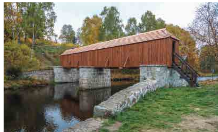
Rechle v Lenoře sloužila k počítání plaveného dřeva po Vltavě. Dřevěná část je nově vybudovaná.
