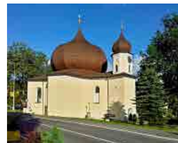
Kostel Panny Marie Pomocné z Hvězdy v Železné Rudě byl vystavěn v letech 1729 až 1732
